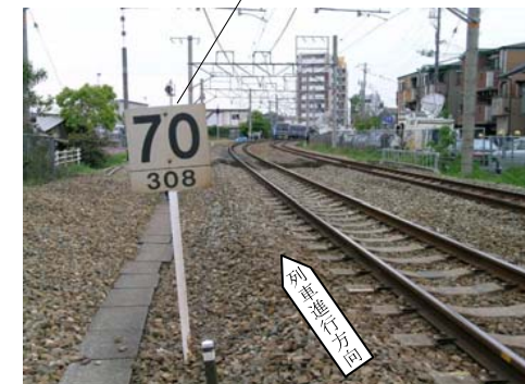
緩和曲線終点及び速度制限標識付近から尼崎駅方を撮影
