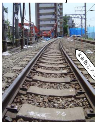
車両の撤去後、列車の最後部付近から尼崎駅方を撮影
