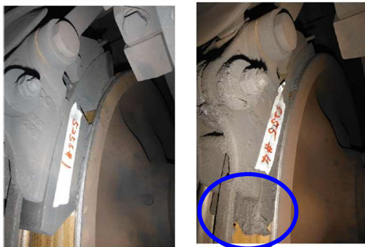
図17 本件事故車両の制輪子。左は付着物の少ない例。右は付着物が堆積した例（青丸枠内）
