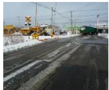
図8 踏切道融雪装置の設置場所の全景例。踏切付近の道路の積雪が少ない。(東日本旅客鉄道株式会社ホームページより)
