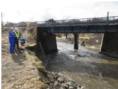
図 2 2 施工完了 (全景)
