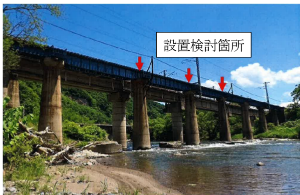
図19 第8馬淵川橋梁（下流側より全景）
