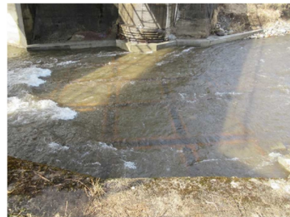
図 2 3 施工完了 (河床底面)
