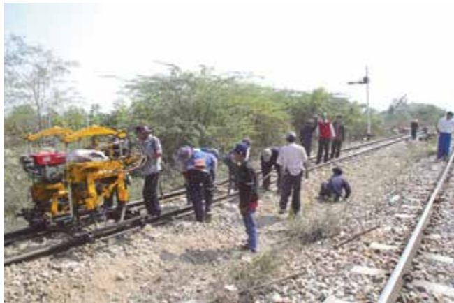
保線作業の様子
