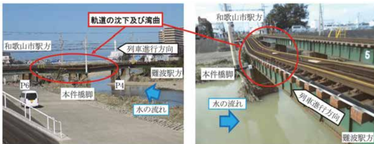
事故現場付近の状況
