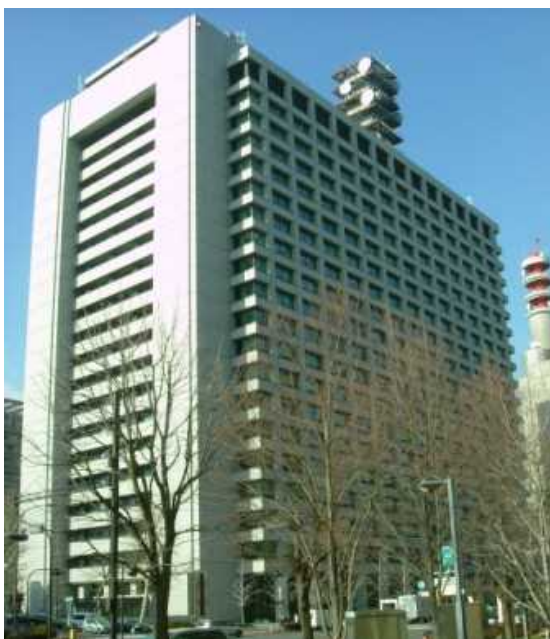
※中央合同庁舎第2号館※
