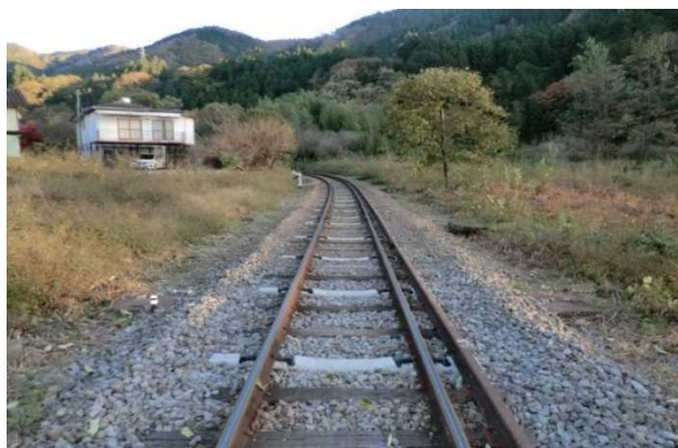
図8 部分PCまくらぎ交換の例
