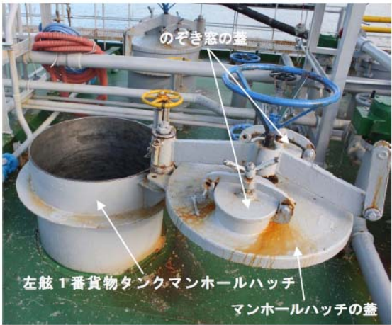
左舷1番貨物タンクマンホールハッチ
