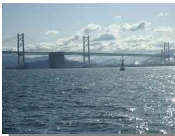
【 南備讃瀬戸大橋 】 橋の高さ 65m（最高水面より）
