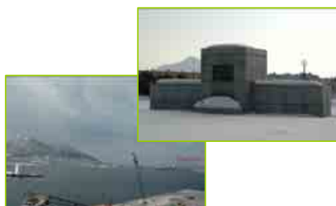
【洞爺丸慰霊碑と函館港（H18.2撮影）】
