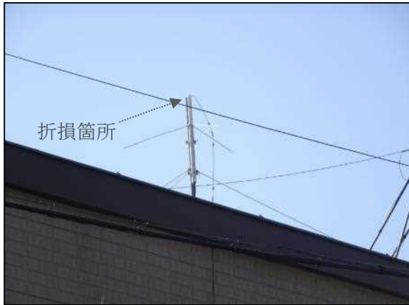
写真6 本件会社事務所の屋外に設置されたアマチュア無線機のアンテナ
