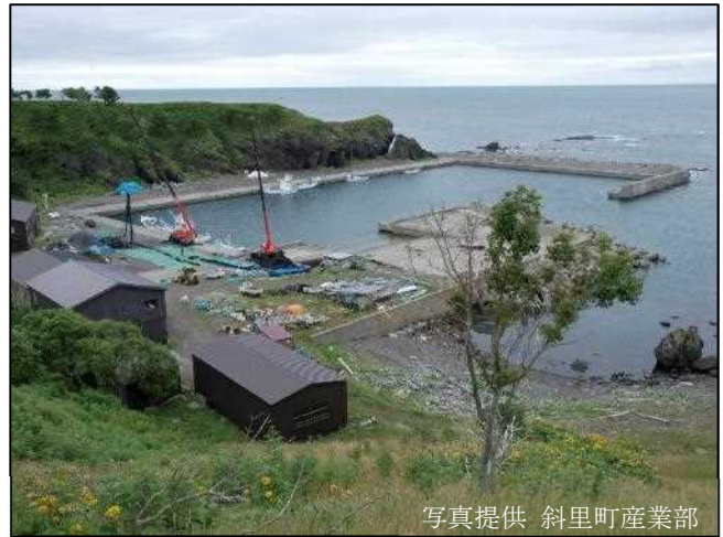
写真33 ムトロ漁港（知床岬地区） 平成21年7月ごろの状況
