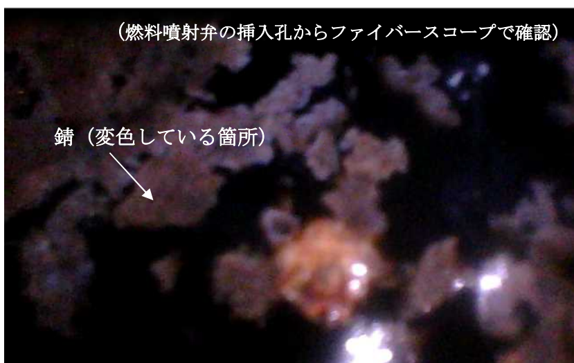
写真18 主機関シリンダ内部
