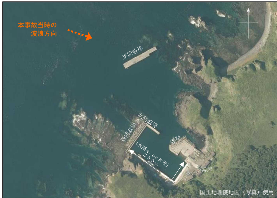
写真34 ウトロ漁港（知床岬地区）の航空写真
