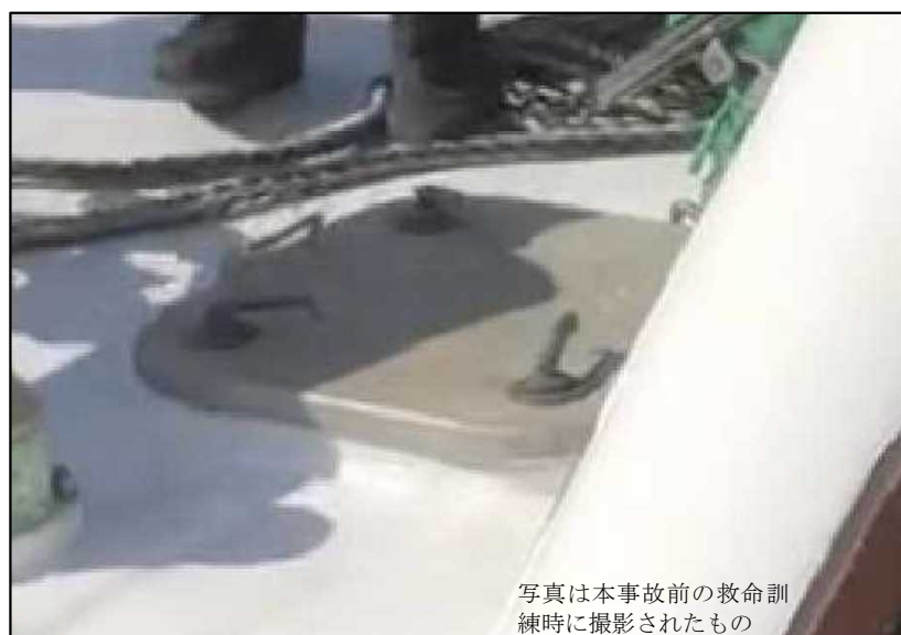
写真 2 7 船首甲板部ハッチ蓋 (拡大)
