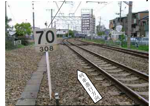
緩和曲線終点及び速度制限標識付近から尼崎駅方を撮影
