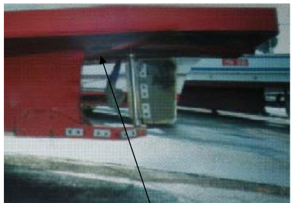
写真3 建造時のA船の左舷船尾の状況
