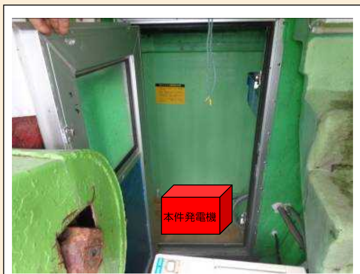
本件区画付近の状況
