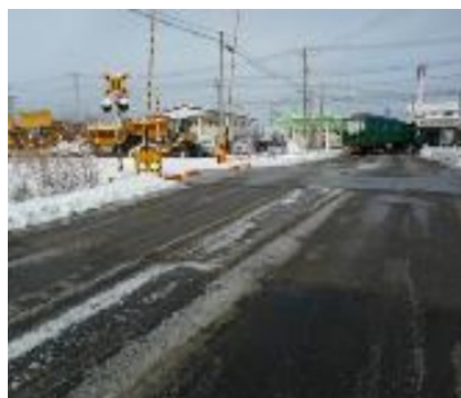
図8 踏切道融雪装置の設置場所の全景例。踏切付近の道路の積雪が少ない。(東日本旅客鉄道株式会社ホームページより)
