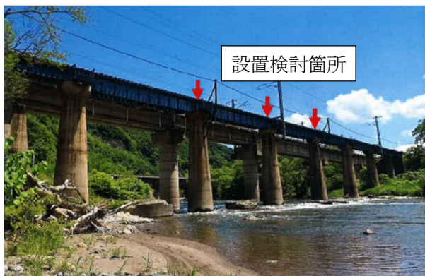
図19 第8馬淵川橋梁（下流側より全景）
