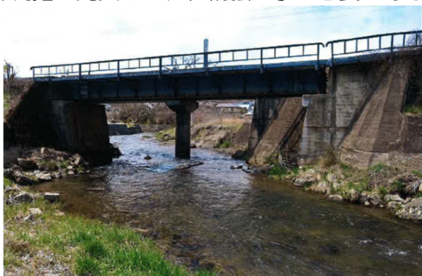
図17 第4北上川橋梁（上流側より全景）
