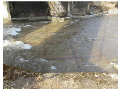
図2-3 施工完了(河床底面)
