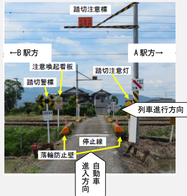
図12 本件踏切の状況(本件自動車進入方向から撮影)
