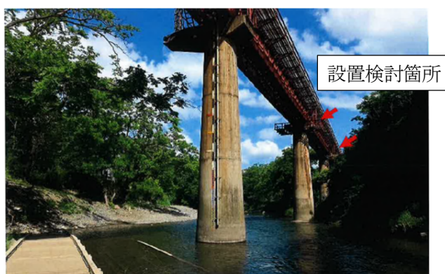
図20 第10馬淵川橋梁（下流側より全景）
