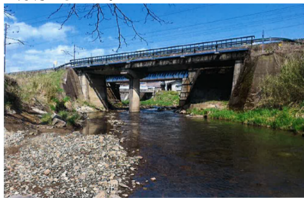
図18 第4北上川橋梁（下流側より全景）
