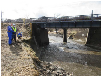
図2-2 施工完了(全景)
