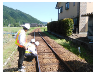
「現地調査」の様子
