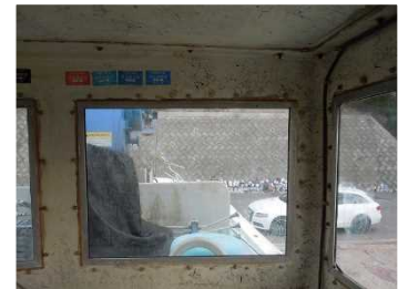
A 船操舵室右舷前面窓
