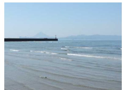
B 風による風浪の状況 防波堤の向こうが港口
