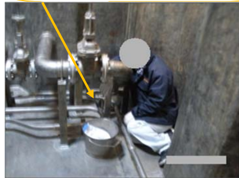
機関長が、二航士を発見したときの状況（左舷1番貨物タンク内）
