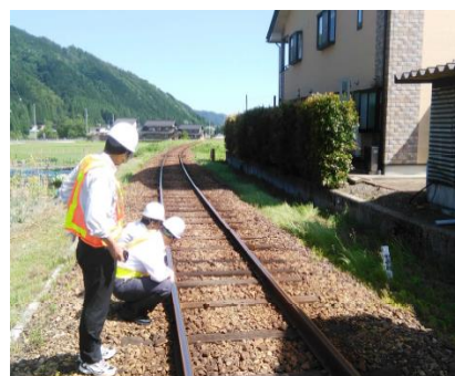
「現地調査」の様子
