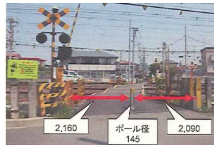
本件踏切の事故前の状況【進入側】数値の単位は「mm」
