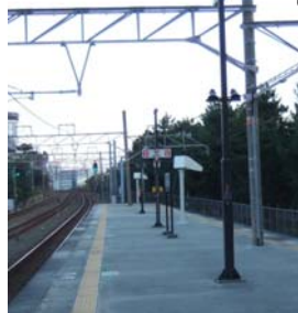
上家がないホームの状況
