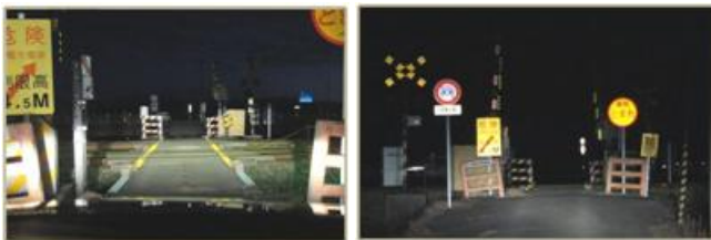
夜間の踏切道の状況（進入側）
