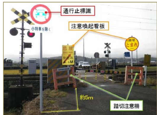
通行止標識と注意喚起看板
