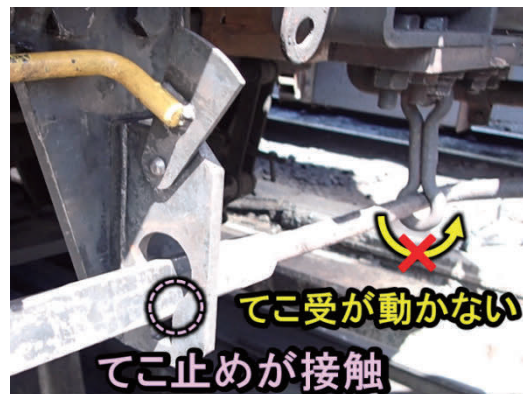
図5 増設のてこ止めが支障
