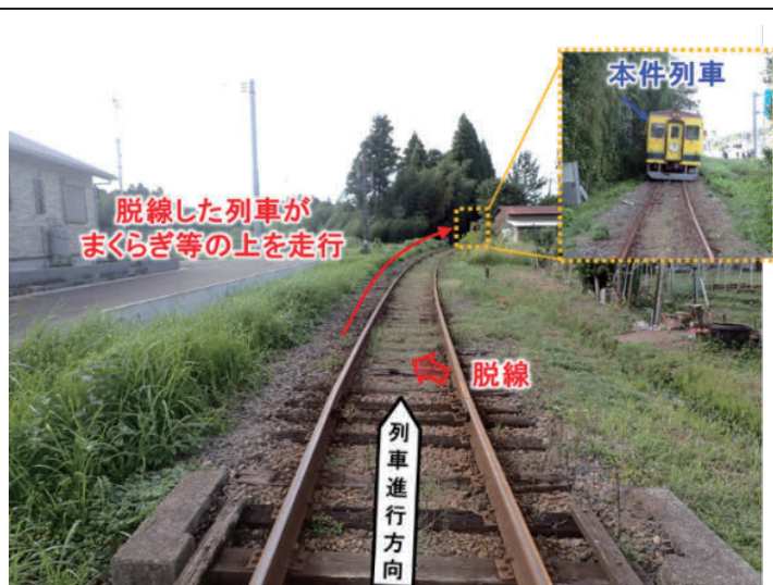
図1 事故現場の状況
