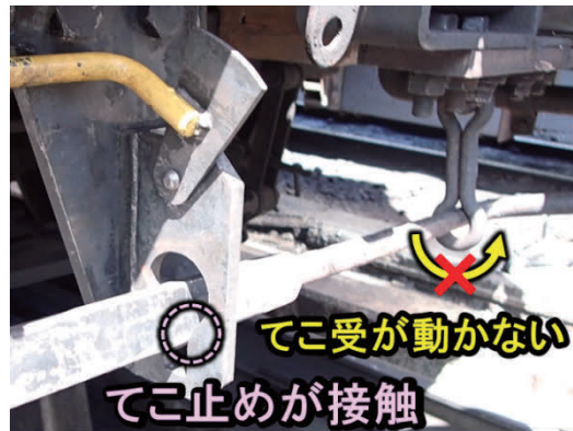
図5 増設のてこ止めが支障
