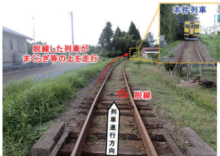
図1 事故現場の状況
