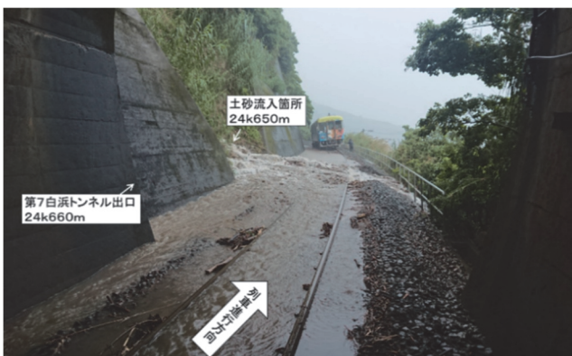
図1 事故現場の状況
