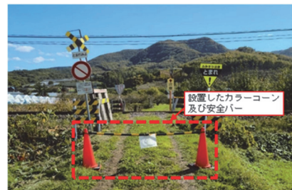
図2 土地所有者による安全対策実施状況
