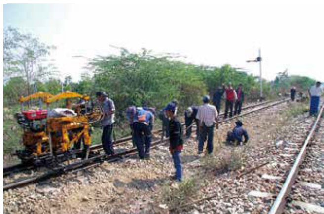
保線作業の様子
