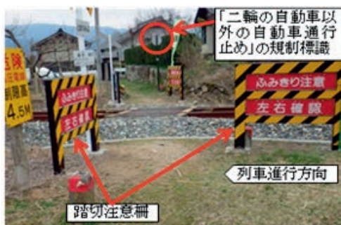
トラクタ進入側から見た踏切
