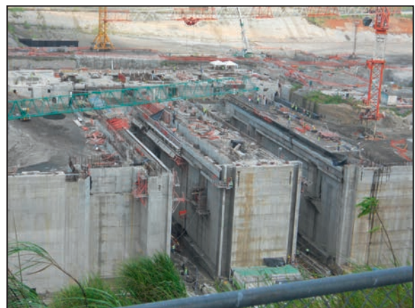
【建設中の閘門】
