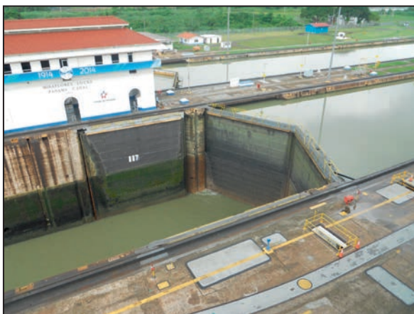
【現在運用中の閘門】
