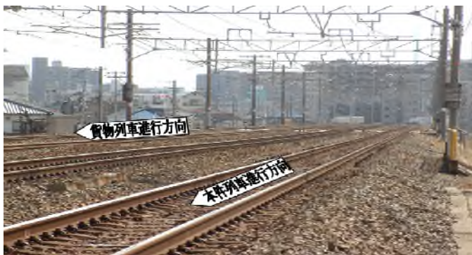
事故現場付近からの明石駅方見通し状況
