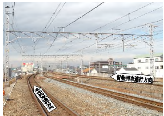
本件列車からの事故現場付近見通し状況
