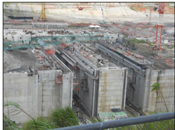
【Locks under construction】
