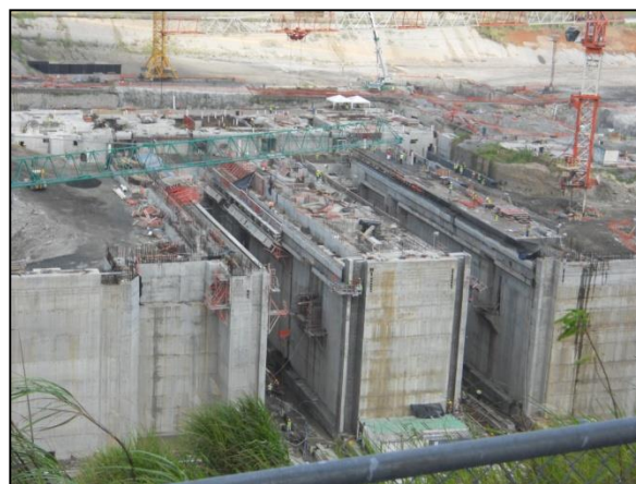
【Locks under construction】
