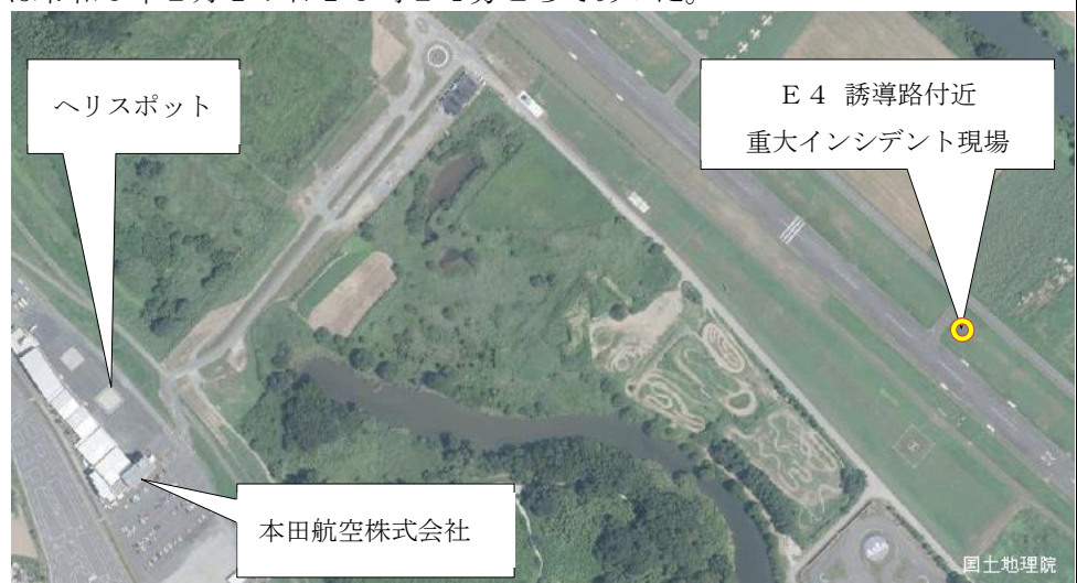
図2 重大インシデント現場
