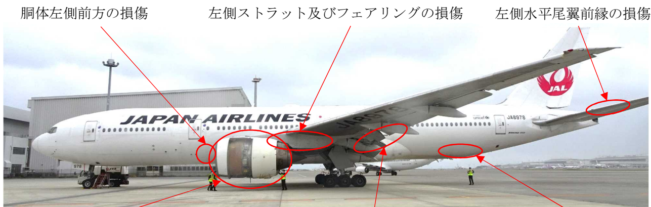
図2 主な損傷部位
