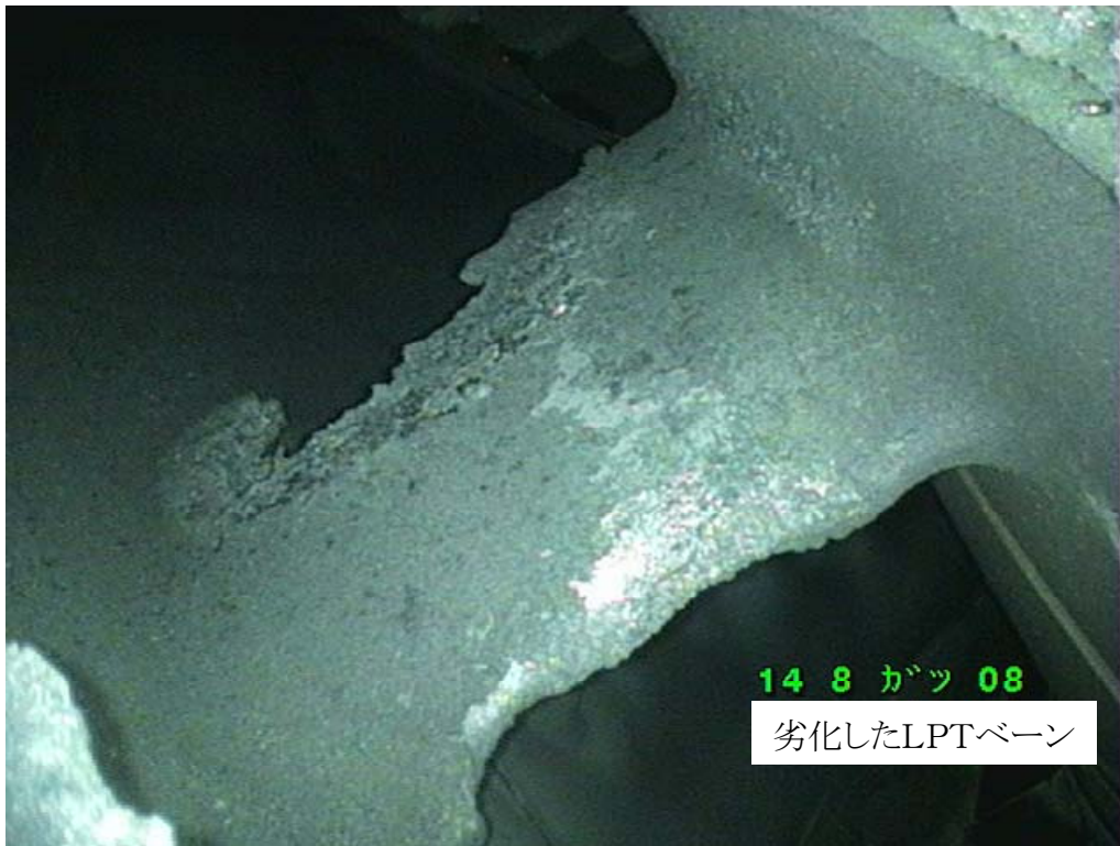
写真7 劣化したLPTベーン<BSI>
