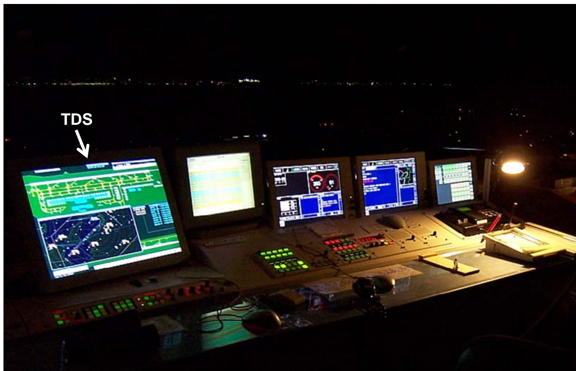
写真1 管制塔（A滑走路側）
