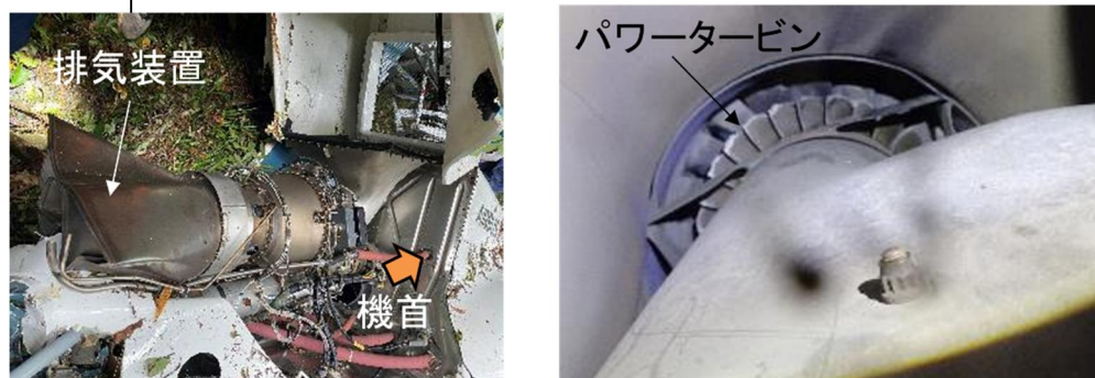
図7 エンジン外観の損傷状況
