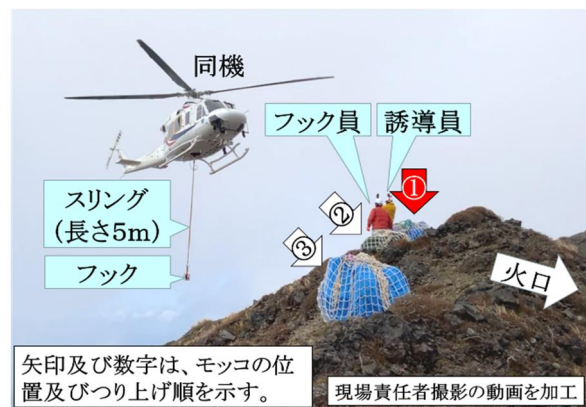
図3 誘導員及びフック員の状況
