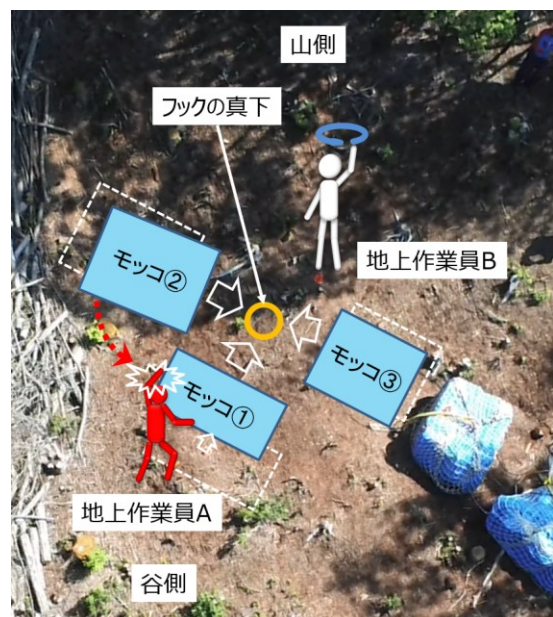
図2 つり上げ作業中
