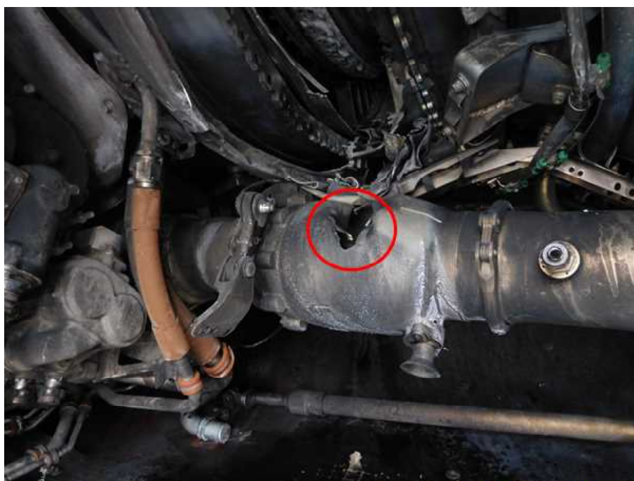
写真# 8 エア・スターター・バルブに開いた穴
