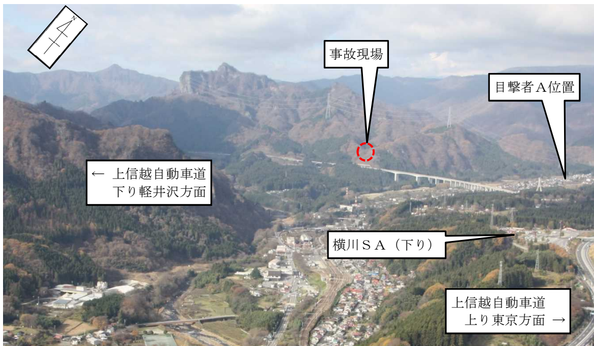
写真2 事故現場付近
