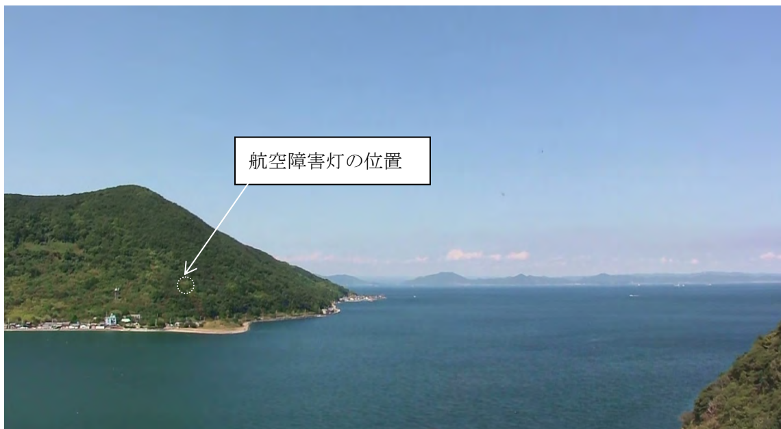
付図6の区間5から見た佐柳島航空障害灯
