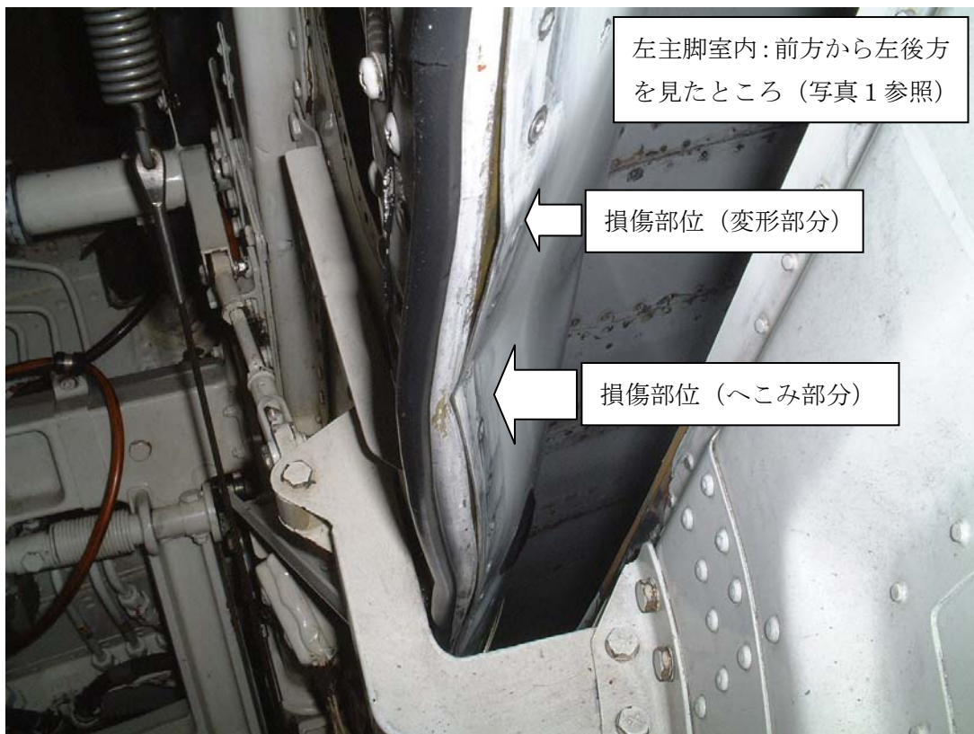
写真4 左主脚室内左側の損傷
