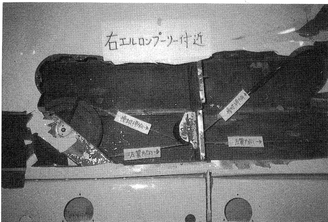
写真3 右エルロンのプーリー付近
