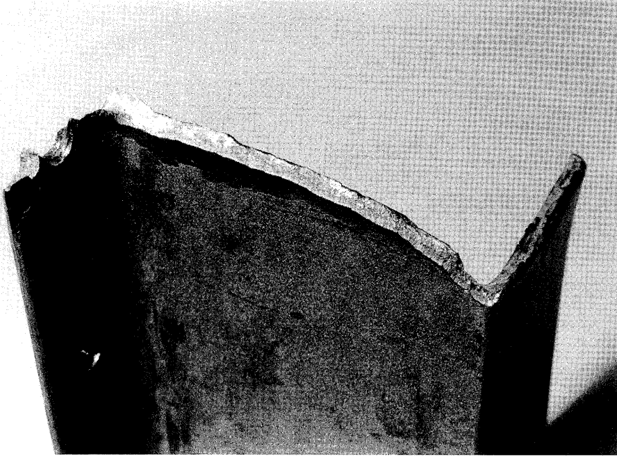
写真-121 L18スティフナの破面ーリベット孔30番目外舷側
