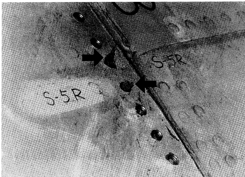
写真- 43 BS2638胴体外板のファスナ孔より 吹き出したとみられる断熱材
