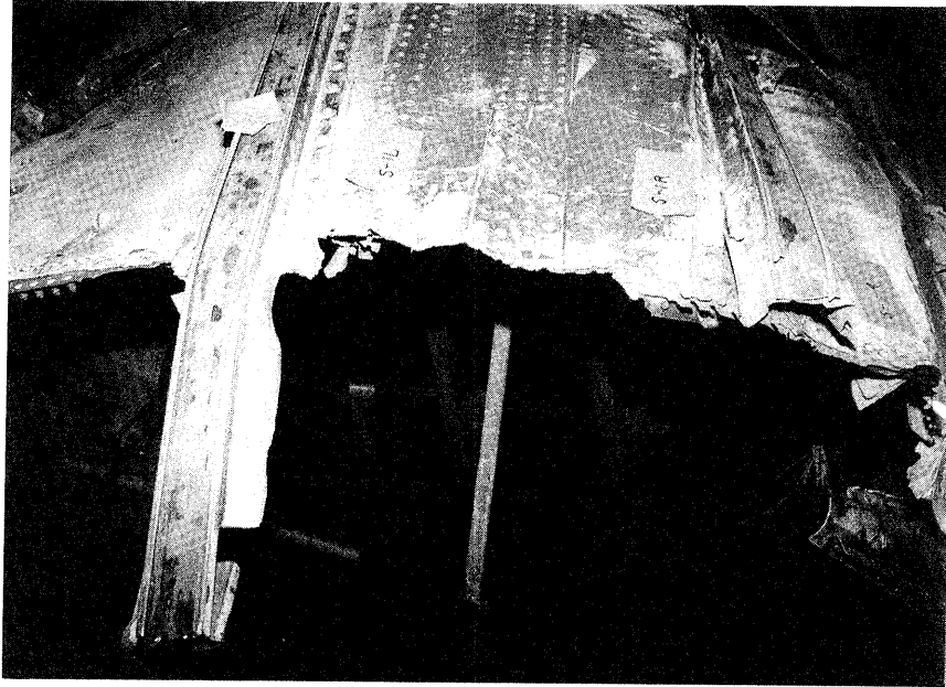
写真- 33 BS2658APU防火壁取付部 1Lと1Rの間の破断状況
